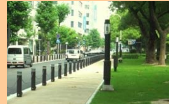
緑地帯再整備(施工後)
